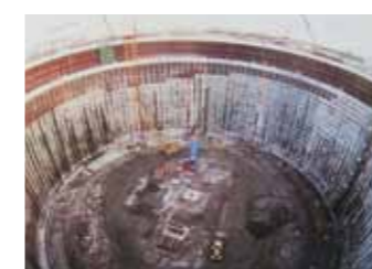
写真4 床付け完了
