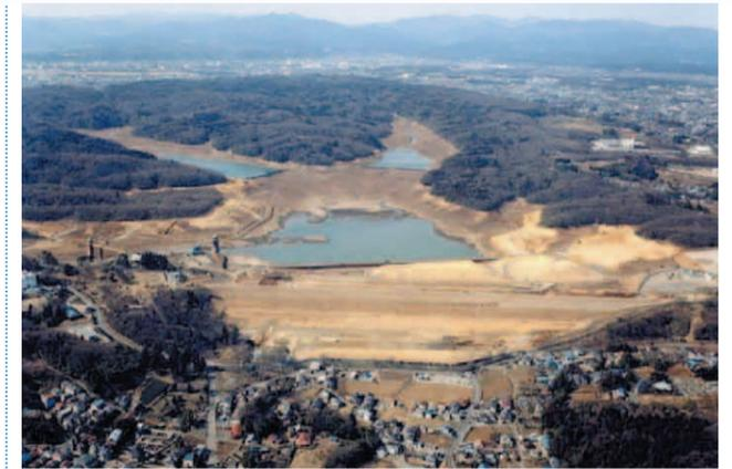
耐弾層撤去、基礎掘削を完了して盛立を開始/平成12年2月撮影
